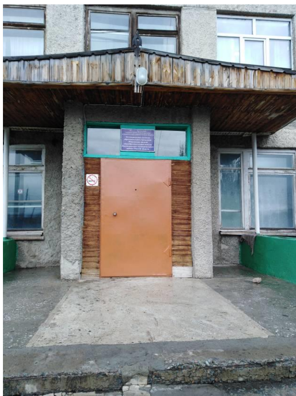
Фото № 4. Входная площадка и входная дверь
